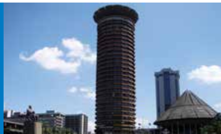
KICC, Nairobi (1000 KVA)
